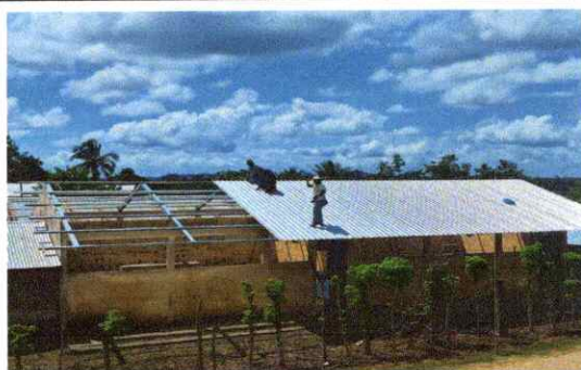
Foto 5: Sustrucción de techo
