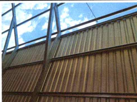
Foto: 3 Sustrucción de estructura
