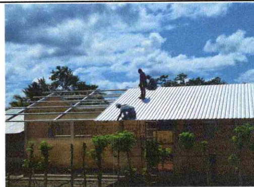
Foto: 2 Sustrucción de estructura
