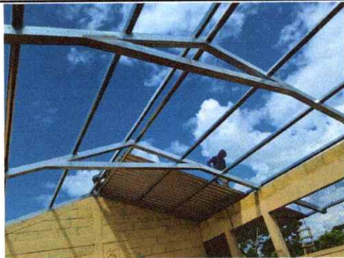
Foto 1: Sustrucción de estructura
