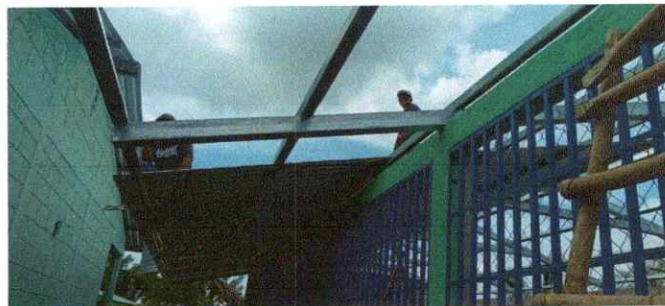
Foto 4: Sustrucción de techo
