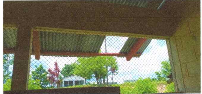
Foto 4: Sustitución de estructura
