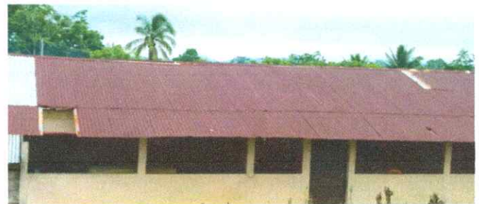
Foto 6: Sustitución de estructura
