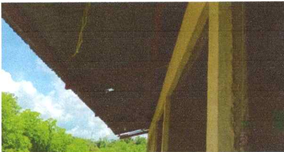
Foto 5: Sustitución de estructura
