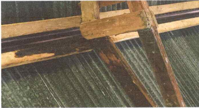
Foto 1: Sustitución de estructura
