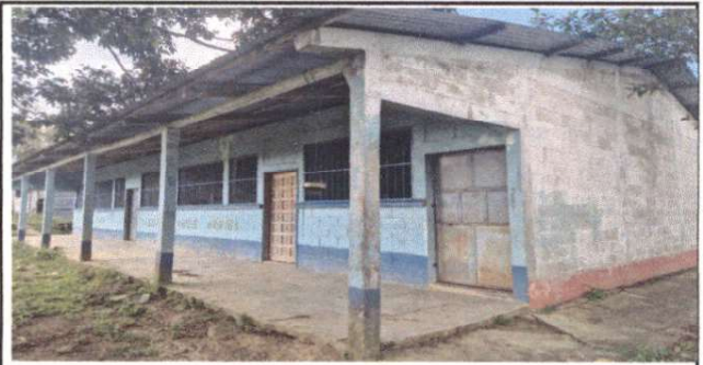
Foto 8: PINTURA DE MUROS EXTERIORES E INTERIORES ✓
