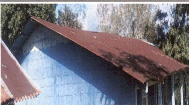
Foto 3: SUSTITUCIÓN DE ELEMENTOS DE FIJACIÓN
