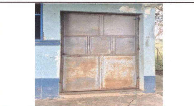
Foto 5: SUSTITUCIÓN DE PUERTAS
