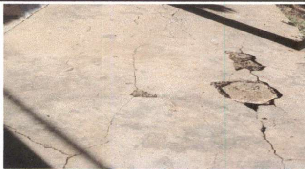
Foto 7: SUSTITUCION DE PISO DE CEMENTO LÍQUIDO ✓
