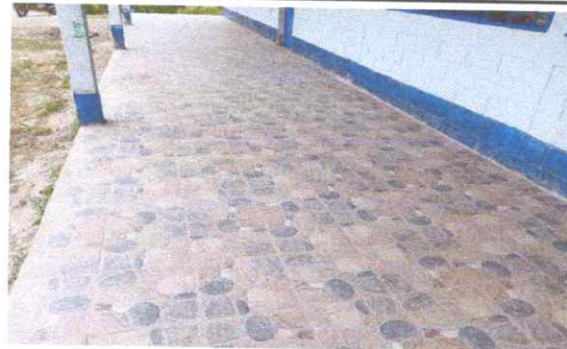
sustitucion de piso de cemento liquido
