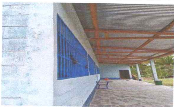
Sustitucion de balcones de metal
