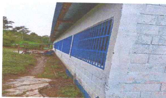
Sustitucion de balcones de metal
