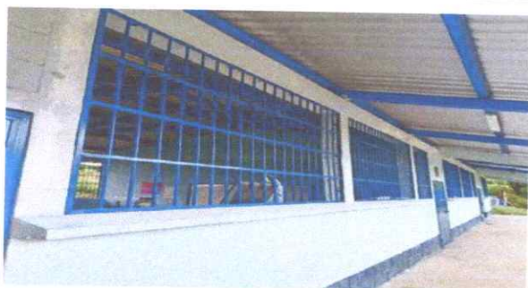
Foto: 5 Sustitucion de balcones de metal
