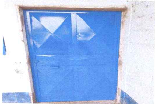
sustitucion de puerta de madera a puerta de metal
