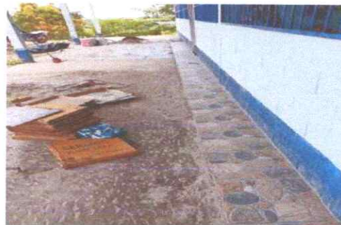
sustitucion de piso de cemento liquido
