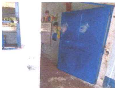
sustitucion de puerta de madera a puerta de metal
