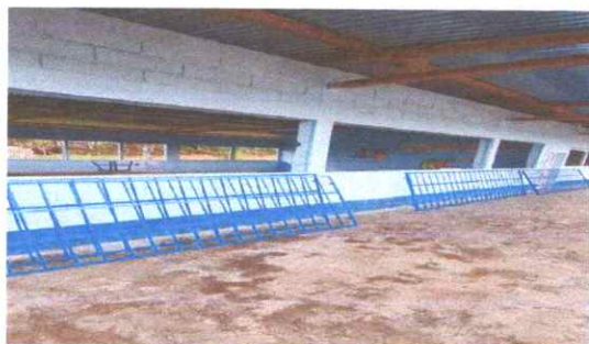
Sustitucion de balcones de metal
