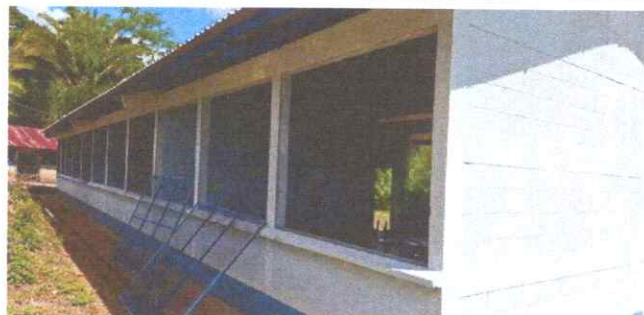
Foto: 5 Sustitucion de balcones de metal
