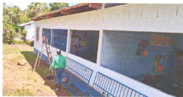
Sustitucion de balcones de metal
