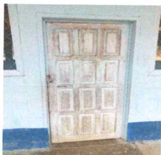
sustitucion de puerta de madera a puerta de metal
