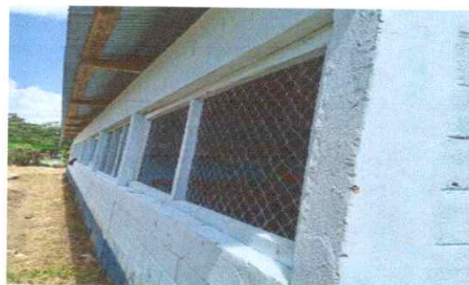
Sustitucion de balcones de metal
