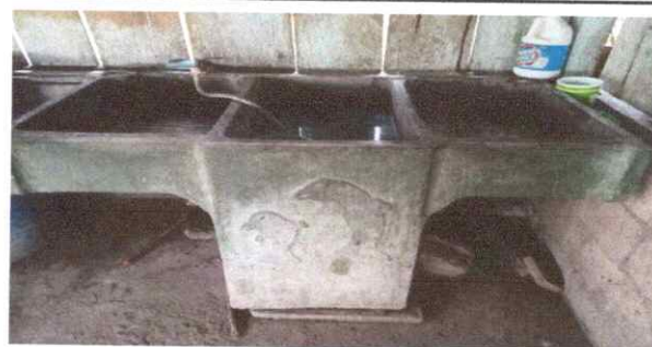
Foto: 6 Sustitucion de pila de cemento con dos lavaderos
