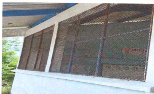
Foto: 5 Sustitucion de balcones de metal
