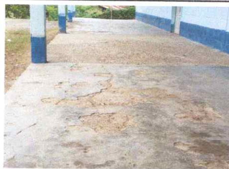
sustitucion de piso de cemento liquido
