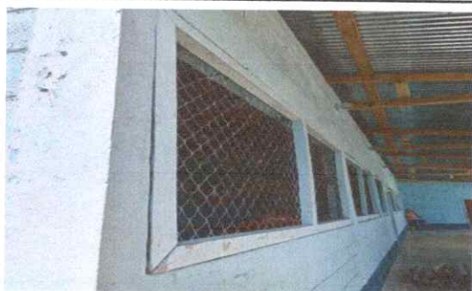
Sustitucion de balcones de metal
