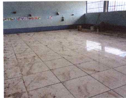
Foto 4: REPARACION DE PISO DE TORTA DE CONCRETO
