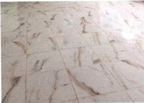
Foto 3: SUSTITUCION DE PISO LISO POR PISO CERAMICO
