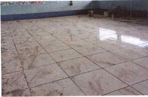
Foto 1: REPARACION DE PISO DE TORTA DE CONCRETO
