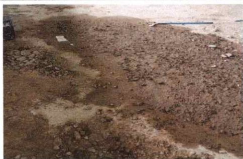
Foto 5: REPARACION DE PISO DE TORTA DE CONCRETO
