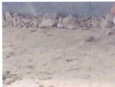
Foto 2: SUSTITUCION DE PISO DE TORTA DE CONCRETO
