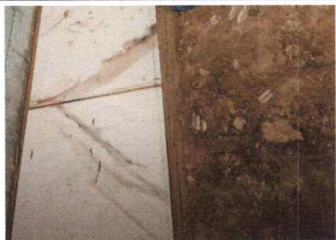
Foto 3: SUSTITUCION DE PISO LISO POR PISO CERAMICO
