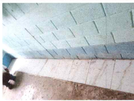
Foto 4: REPARACION DE PISO DE TORTA DE CONCRETO
