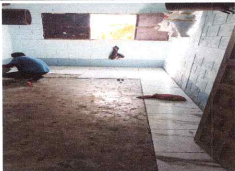
Foto 1: REPARACION DE PISO DE TORTA DE CONCRETO
