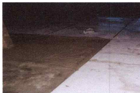
Foto 6: REPARACION DE PISO DE TORTA DE CONCRETO
