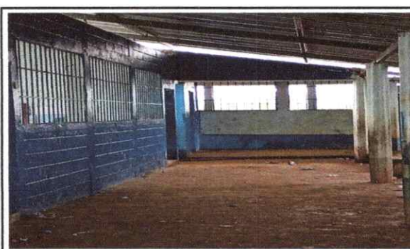
Foto 4: REPARACION DE PISO DE TORTA DE CONCRETO
