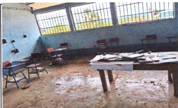
Foto 3: MEJORAMIENTO DE PISO LISO POR PISO CERAMICO
