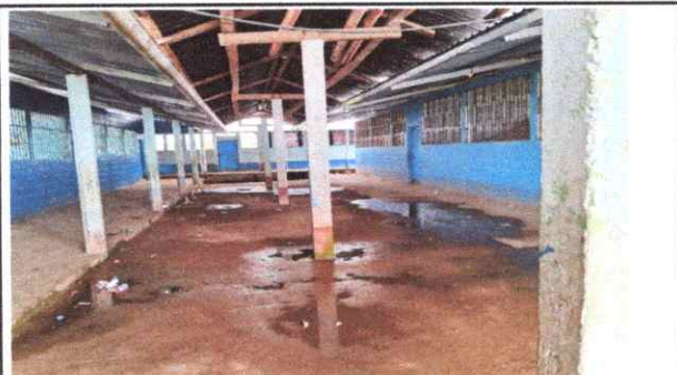
Foto 1: REPARACION DE PISO DE TORTA DE CONCRETO
