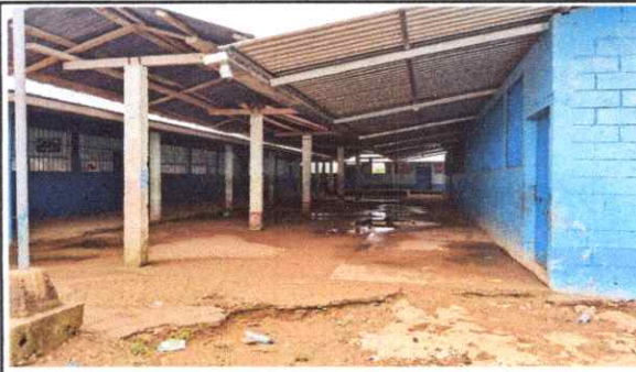
Foto 2: SUSTITUCION DE PISO DE TORTA DE CONCRETO
