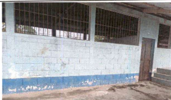
Foto 9: Mantenimiento a balcones de metal
