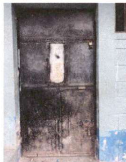
Foto 4: Mantenimiento de puertas de metal.
