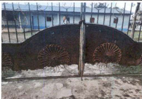
Foto 5: Mantenimiento a porton de entrada principal.
