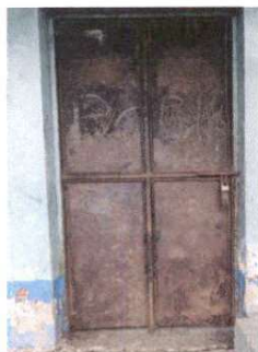
Foto 1: Fabricación e instalación de puerta de metal en módulo.
