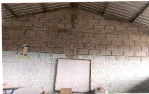
Foto 8: Aplicación de pintura en interior y exterior.
