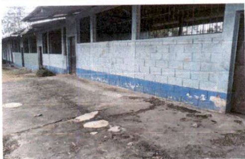
Foto 7: Reparación de torta de concreto.
