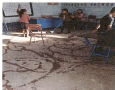
Foto 6: Sustitución de piso de cemento líquido.
