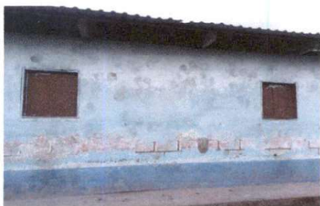
Foto 3: Fabricación e instalación de ventana-balcon de metal
