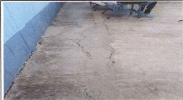
Foto 2: Sustrucción de piso de torta de cemento líquido.
