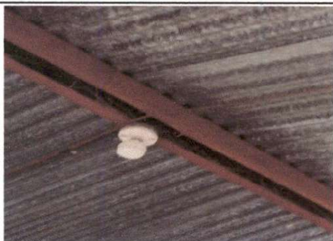
Foto1: SUSTITUCION DE LAMPARAS TIPO LED
