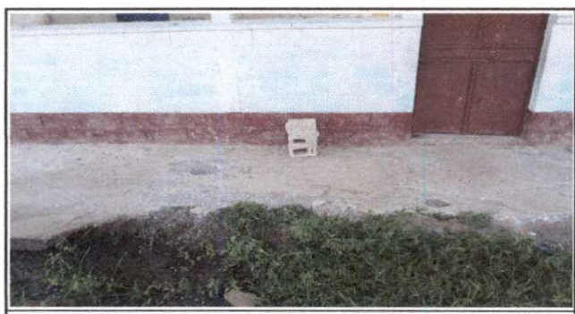
Foto 5: REPARACION DE BANQUETA DE CONCRETO
