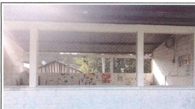
Foto 4: SUSTITUCION DE BALCONES DE METAL
