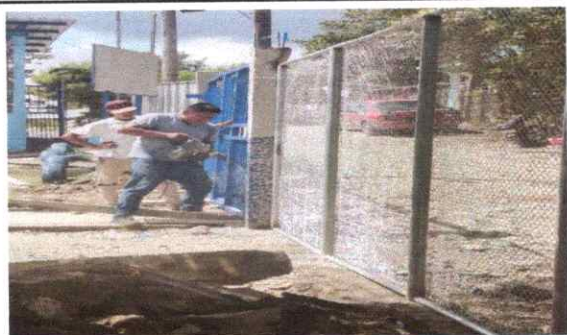
Foto 3: Reparación de muro perimetral de malla por malla
