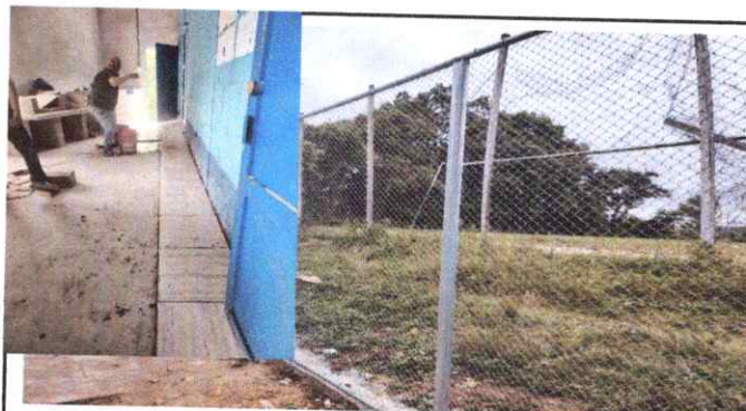
Foto 2 Reparación de muro perimetral de malla por muro perimetral de tubos galvanizados y malla.
