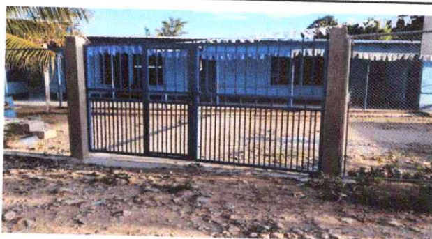
Foto: 3 fabricación e instalación de porton de metal
