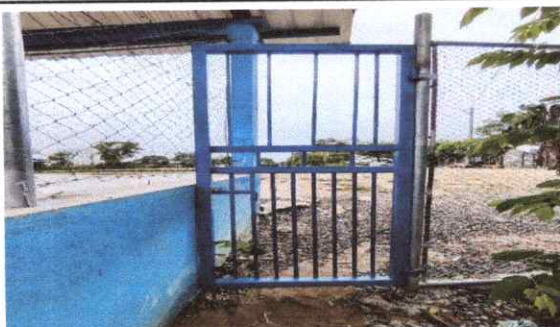
Foto 1: Porton de entrada al campo.
