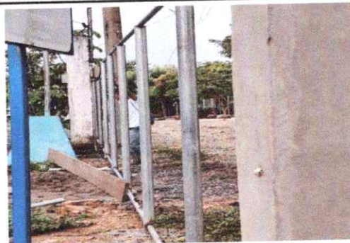
Foto 2: Reparación de muro perimetral de malla por muro perimetral de tubos galvanizados y malla
