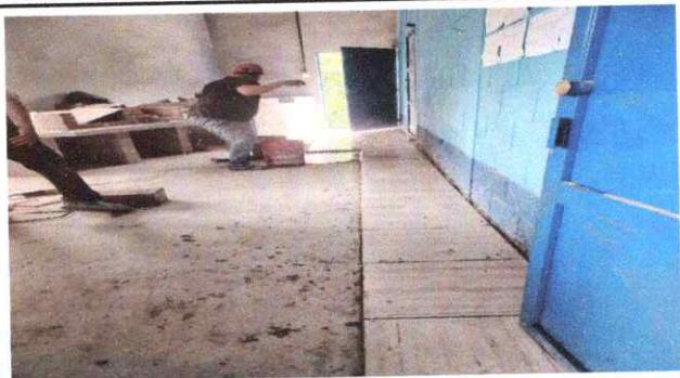
Foto 1: Mejoramiento de piso de torta de concreto por piso cerámico
