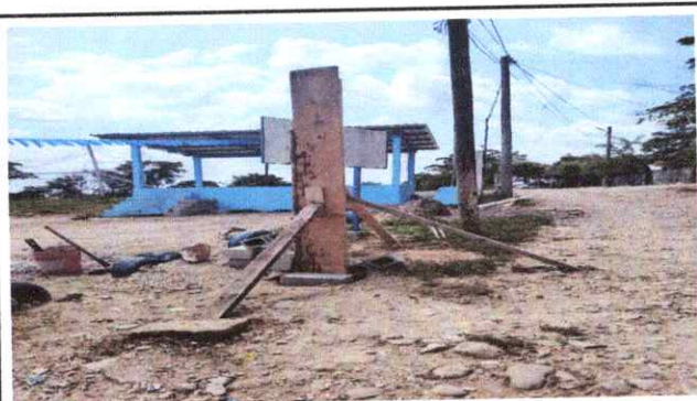
Foto 3: fabricación e instalación de porton de metal
