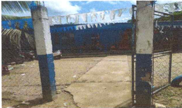
Foto 3: fabricación e instalación de porton de metal
