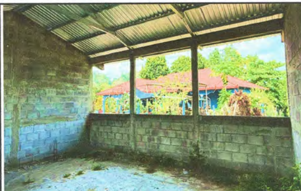
Foto: 4 Repello en muro
