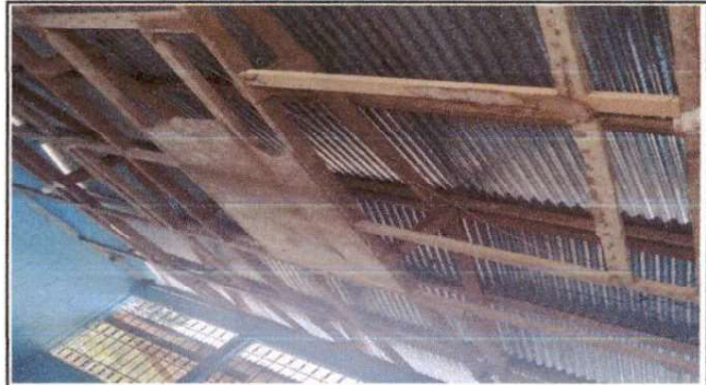
FOTO 2: SUSTITUCION DE CAPOTE DE LÁMINA PARA LAMINA TROQUELADA
