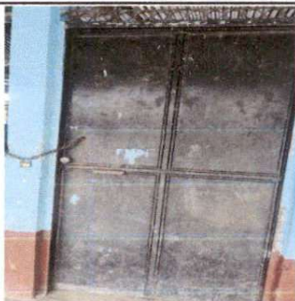
FOTO 5: SUSTITUCION DE PUERTA
