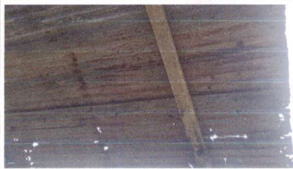
FOTO 3: SUSTITUCION DE ELEMENTOS DE FIJACION
