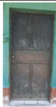
Foto 4: Sustitución de puerta
