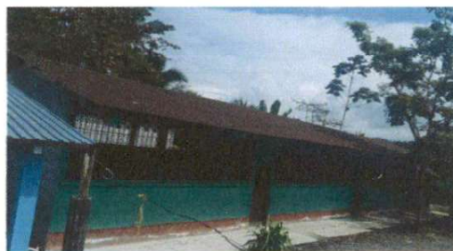
Foto 6: Pintura en muros exteriores e interiores
