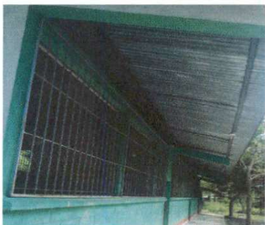
Foto 5: Mantenimiento a barandas de metal
