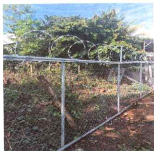
Foto: 5 Construcción de malla perimetral
