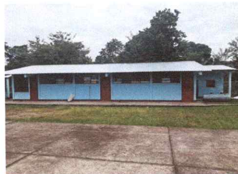
Foto: 2 Sustitución de lamina
