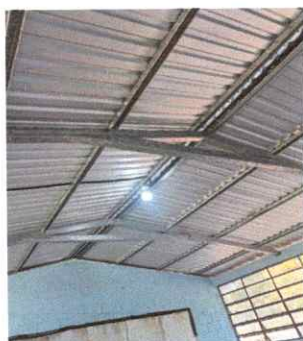
Foto: 3 Sustitución de estructuras
