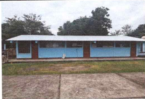
Foto 1: Sustitución de lamina
