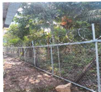
Foto: 6 Construcción Malla Perimetral
