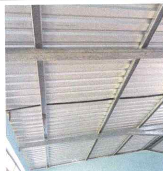
Foto: 4 Sustitución de lamina
