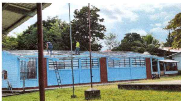
Foto 3 Sustrucción de estructuras
