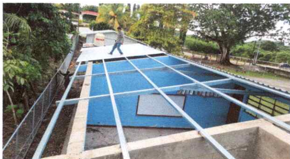
Foto 1: Sustrucción de lamina
