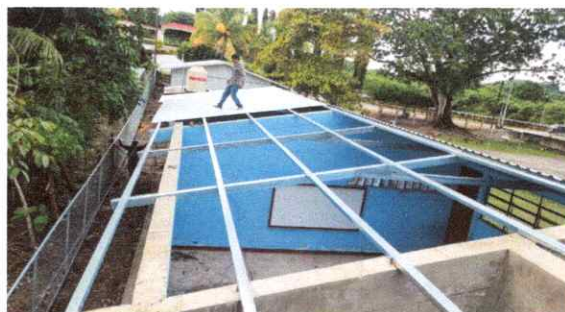
Foto 2 Sustrucción de lamina
