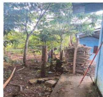
Foto 6 Construcción Malla Perimetral
