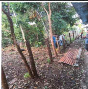
Foto 5 Construcción de malla perimetral
