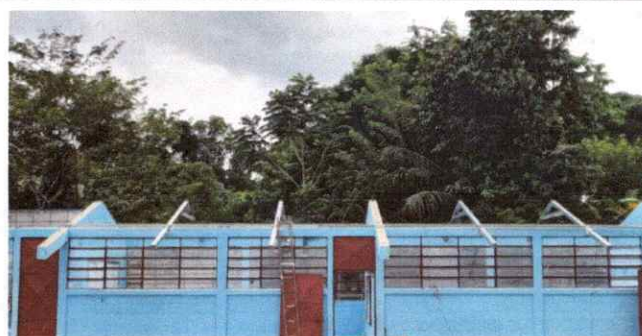
Foto 4 Sustrucción de lamina
