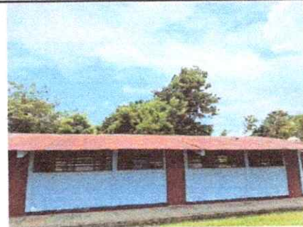
Foto 4 Sustrucción de lamina
