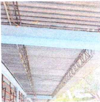
Foto 1 Sustrucción de estructura
