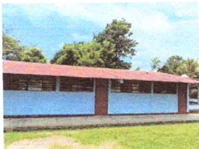
Foto 5 Sustrucción de lamina
