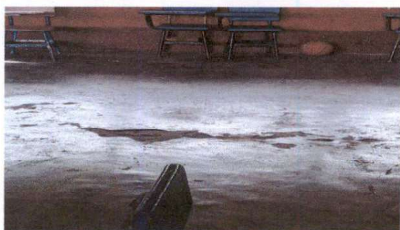
Foto 3: Sustitución de cemento líquido.
