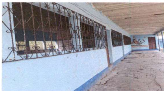
Foto 5: Sustitución de elementos de fijación
