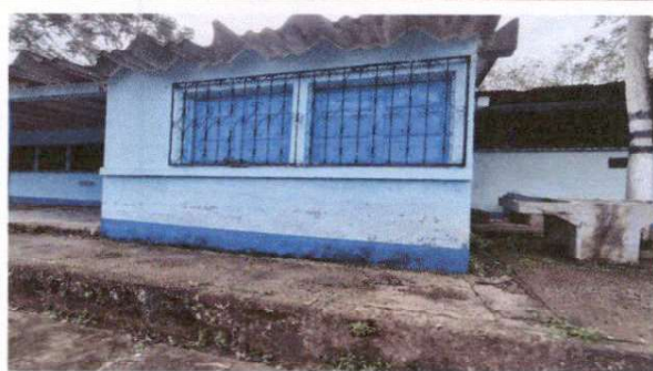
Foto 4: Sustitución de ventanas de madera por metal más vidrio.
