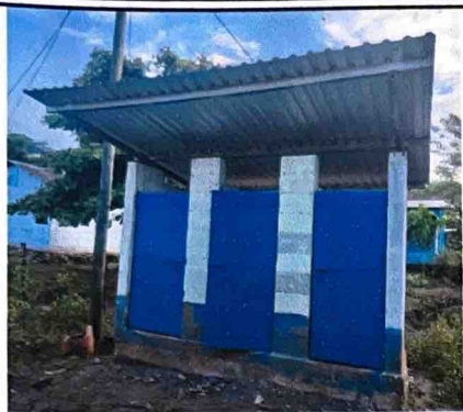
Foto 1: Sustrucción de lámina, por lámina troquelada aluzinc calibre 26, Sustrucción de estructura de soporte de madera, por metal, Reparación de piso de torta de concreto sanitario
