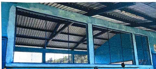
Foto 1: Sustrucción de lámina, por lámina troquelada aluzinc calibre 26, Sustrucción de estructura de soporte de madera, por metal, Reparación de piso de torta de concreto sanitario
