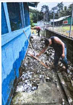
Foto 5: Reparación de cuneta de concreto; Reparación de banquetas de concreto
