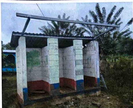
Foto 1: Sustrucción de lámina, por lámina troquelada aluzinc calibre 26, Sustrucción de estructura de soporte de madera, por metal, Reparación de piso de torta de concreto sanitario
