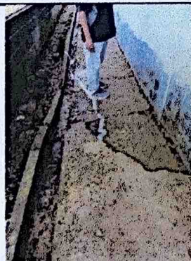
Foto 5: Reparación de cuneta de concreto; Reparación de banquetas de concreto
