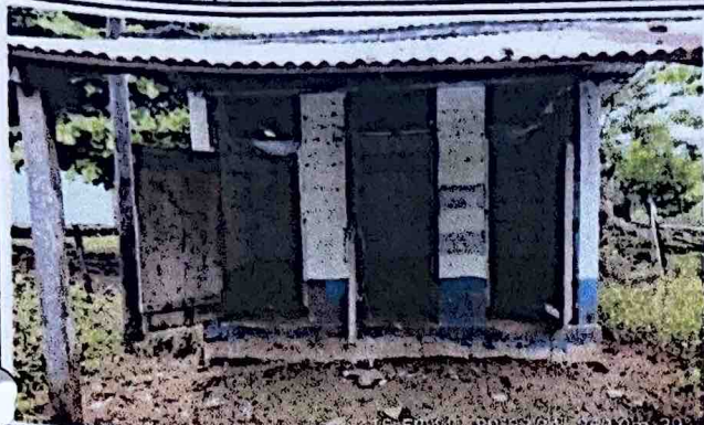
Foto 1: Sustrucción de lámina, por lámina troquelada aluzinc calibre 26, Sustrucción de estructura de soporte de madera, por metal, Reparación de piso de torta de concreto sanitario
