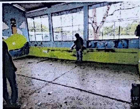
Foto 4: Reparación de piso de torta de concreto, Mejoramiento de piso liso por piso Cerámico (Aulas)
