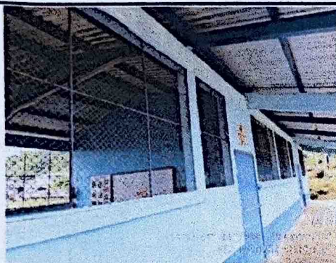
Foto 3: Mantenimiento a balcones de metal
