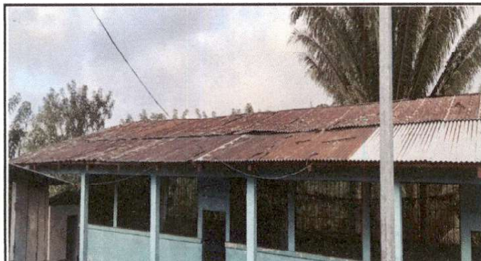
Foto 3: Sustitución de lamina por lamina troquelada calibre 26.
