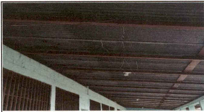
Foto 2: Sustitución de ducto electrico mas accesorios.
