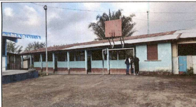
Foto1: Pintura en muros interiores y exteriores.
