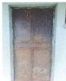
FOTO 4: SUSTITUCION DE PUERTAS DE METAL
