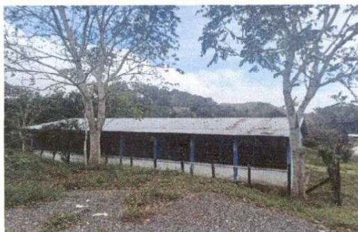
FOTO 1: SUSTITUCION DE LAMINA, POR LAMINA TROQUELADA ALUZING CALIBRE 26
