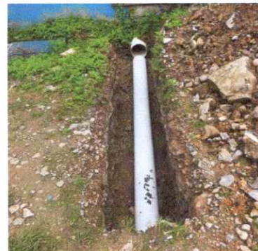
FOTO 7: INSTALACIÓN DE TUBO
