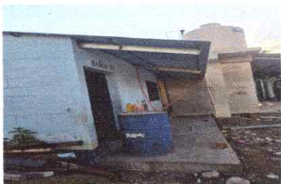
FOTO 3: SUSTITUCION DE LAMINA TROQUELADA ALUZINC CALIBRE 26
