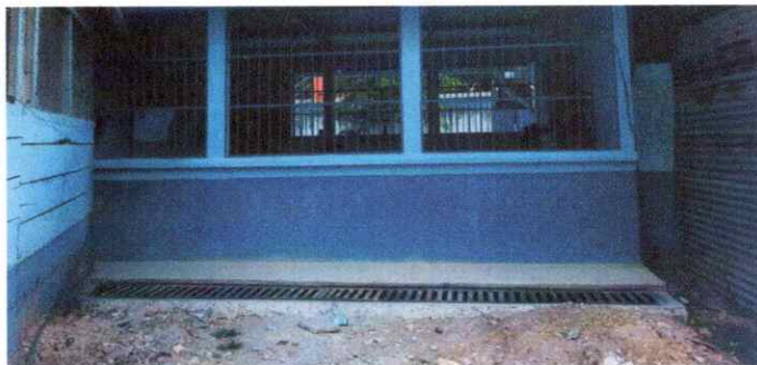
FOTO 6: REPARACIÓN DE CUNETA DE CONCRETO+REJILLA
