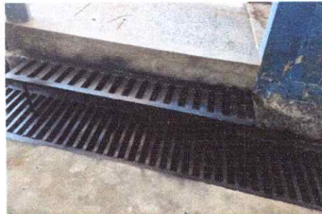
FOTO 2: REPARACION DE CUNETA DE CONCRETO+REJILLA
