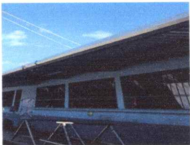
FOTO 1: REPARACION DE CANAL PVC
