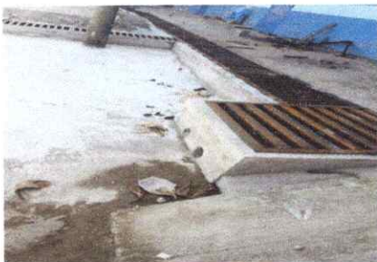
FOTO 5: REPARACION DE CAJA DE REGISTRO.
