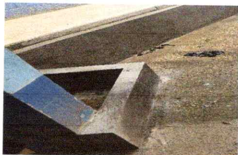
FOTO 5: REPARACION DE CAJA DE REGISTRO.
