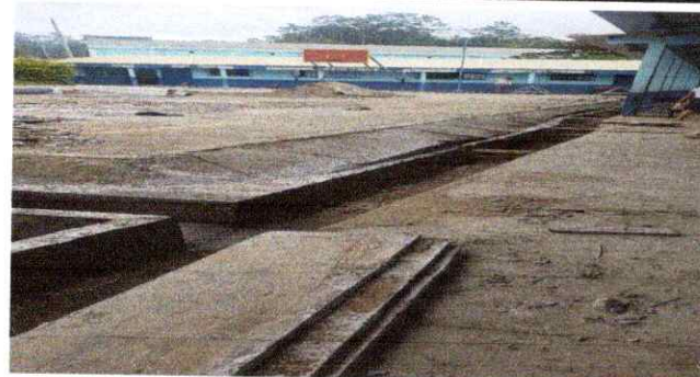
FOTO: 2 REPARACION DE CUNETA DE CONCRETO+REJILLA
