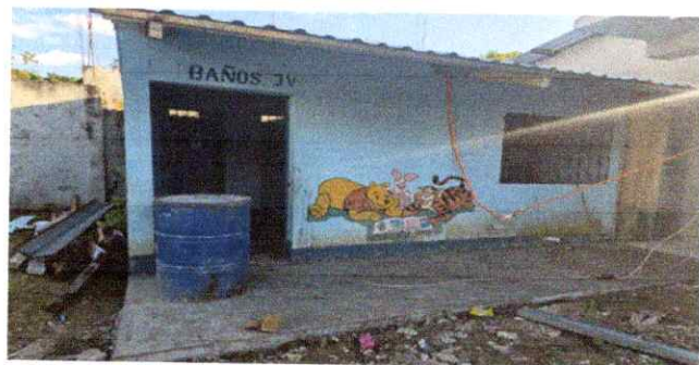
FOTO 3: SUSTITUCION DE LAMINA TROQUELADA ALUZINC CALIBRE 26
