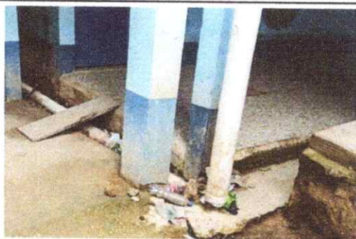
Foto 5: Reparación de Caja de Registro
