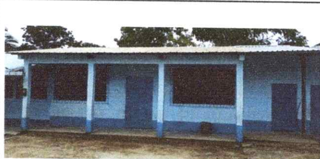
Foto 1: CANALES Y BAJADAS DE AGUA PLUVIAL
