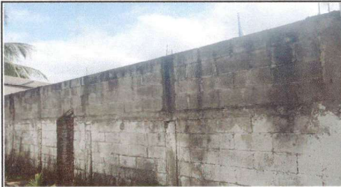
Foto 4: Reparación de muro perimetral de Block.
