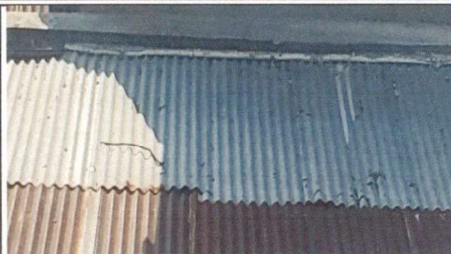
Foto 2: Sustrucción e instalación de lámina, por lámina troquelada aluzinc calibre 26 y elementos de fijación.
