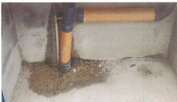
Foto1: Sustrucción de tubería PVC línea principal aguas negras.
