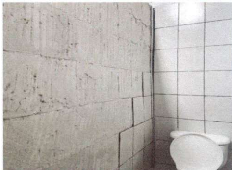
Foto 2: Sustitución de azulejo.
