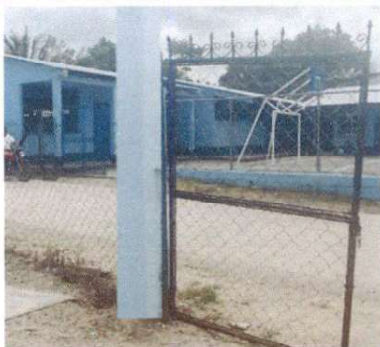
Foto 1: Fabricación e instalación de portón de metal de ingreso.
