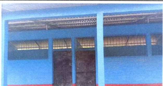
Foto 5: FABRICACIÓN DE BALCONES
