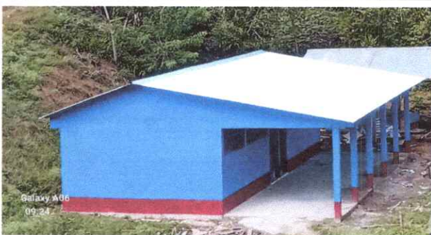
Foto 3: Pintura en muros exteriores e interiores
