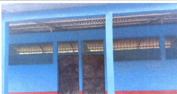
Foto 5: FABRICACIÓN DE BALCONES
