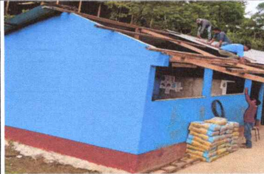
Foto 2: Sustrucción de estructura de soporte de metal, por metal
