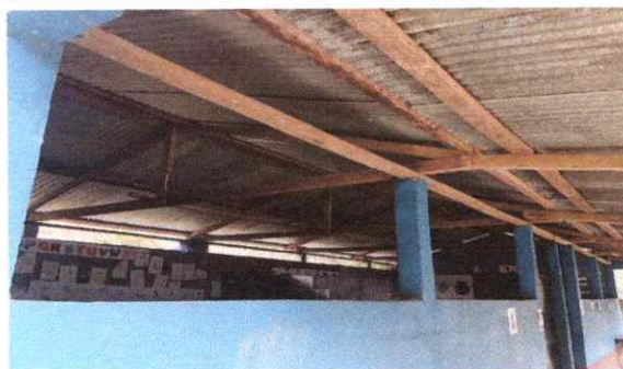
Foto 2: Sustitución de estructura de soporte de metal, por metal
