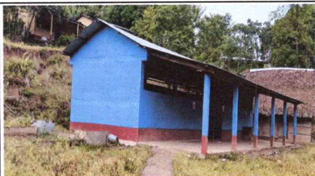
Foto 3: Pintura en muros exteriores e interiores
