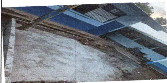
FOTO 4: SUSTITUCIÓN DE PISO DE TORTA DE CONCRETO
