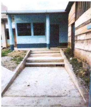
FOTO 5: GRADA FRENTE A LA COCINA CON SU BORDILLO
