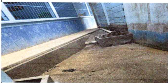
FOTO 3: REPARACIÓN DE CAJA DE REGISTRO
