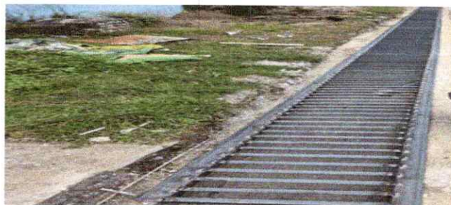
FOTO 2: REPARACIÓN DE CUNETA DE CONCRETO + REJILLA
