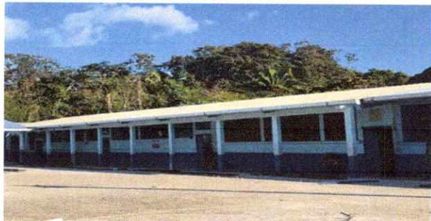
FOTO 1: REPARACIÓN DE CANAL PVC
