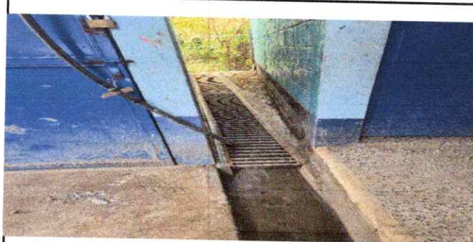
FOTO 2: REPARACIÓN DE CUNETA DE CONCRETO +REJILLA
