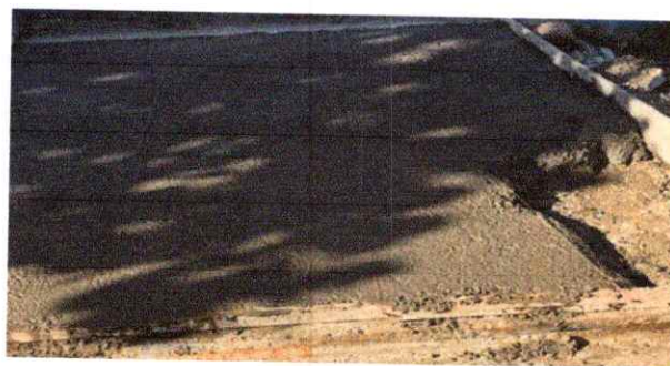
FOTO 4: REPARACIÓN DE TORTA DE CONCRETO
