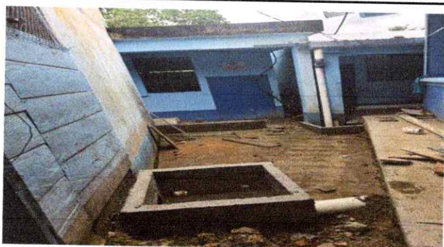
FOTO 3: REPARACIÓN DE CAJA DE REGISTRO
