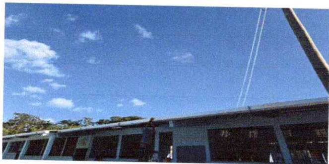
FOTO 1: REPARACIÓN DE CANAL PVC
