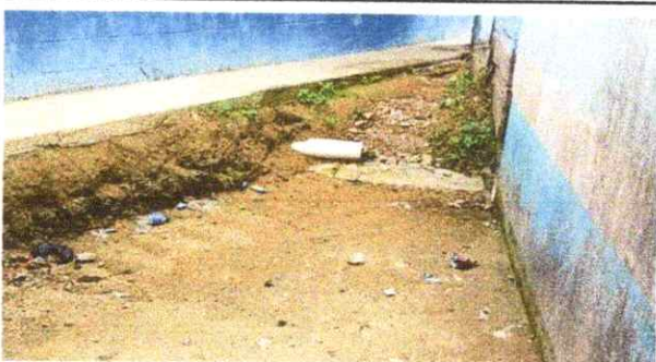
Foto 3: Reparación de Caja de Registro
