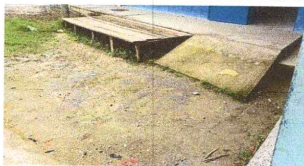
Foto 4: Sustitución de piso de torta de concreto
