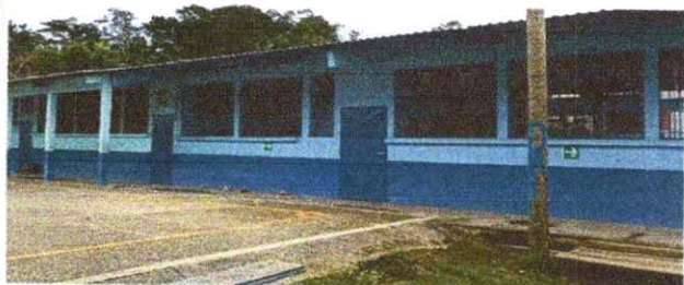
Foto 1: Reparación de canal de PVC
