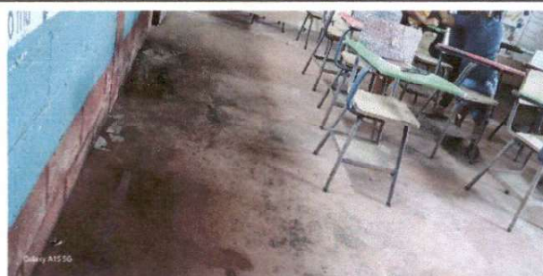
FOTO 4: SUSTITUCION DE PISO
