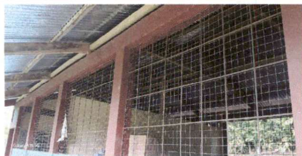
FOTO 5: SUSTITUCION DE BALCONES
