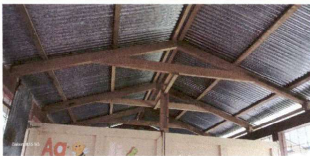
FOTO 2: SUSTITUCION DE ESTRUCTURA DE MADERA, POR METAL
