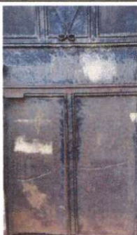
FOTO 3: SUSTITUCION DE PUERTA
