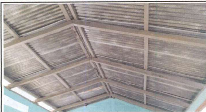
Foto1: Sustitución de lamina por lamina troquelada calibre 26.
