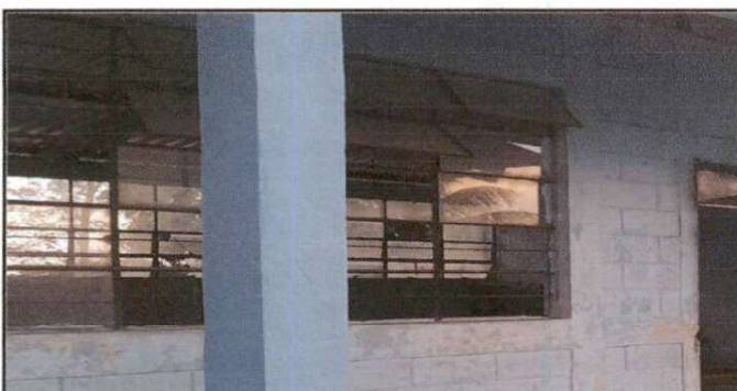
Foto 5: . Sustitución de balcones de metal.
