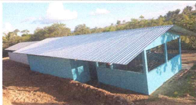
Foto 1: sustitucion de lamina , por lamina troquelada aluzinc
