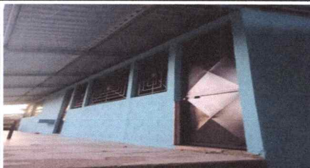
Foto 2: Sustitucion de soporte de madera por metal
