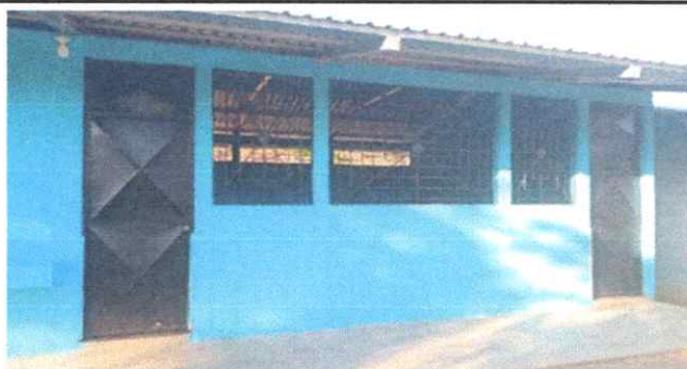
Foto 3: Mantenimiento de estructura en puerta
