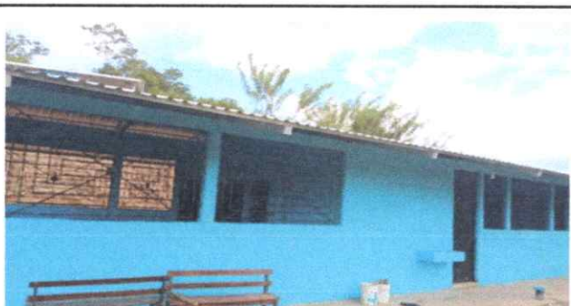
Foto 5: Mantenimiento de balcones de metal
