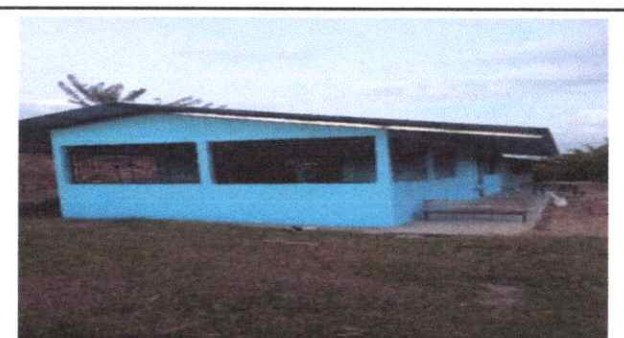
Foto 6: Pintura en muro externo e interno
