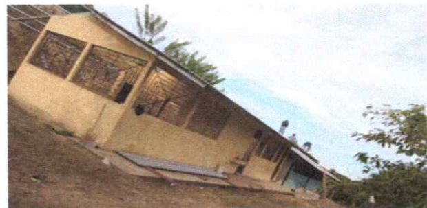
Foto 6: Pintura en muro externo e interno
