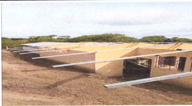
Foto 1: sustitucion de lamina , por lamina troquelada aluzinc
