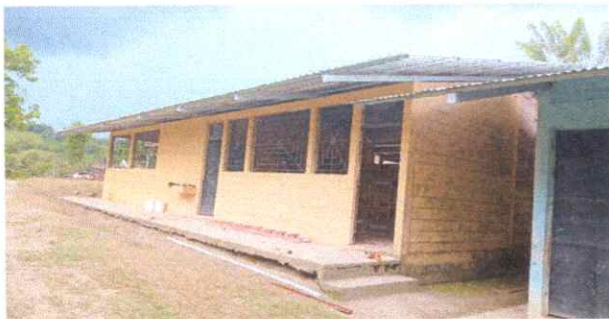
Foto 3: Mantenimiento de estructura en puerta
