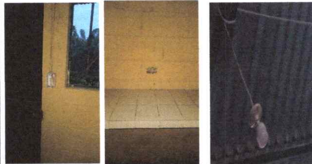
Foto 4: Reparacion de sistema electrico
