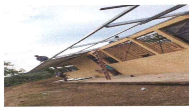
Foto 2: Sustitucion de soporte de madera por metal
