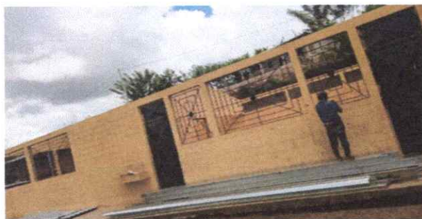
Foto 5: Mantenimiento de balcones de metal
