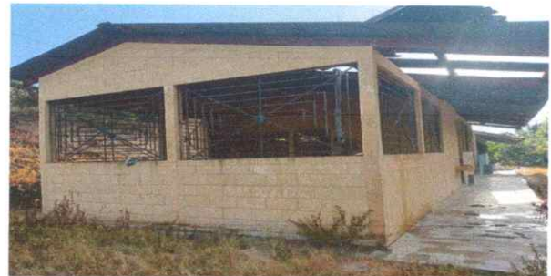
Foto 6: Pintura en muro externo e interno
