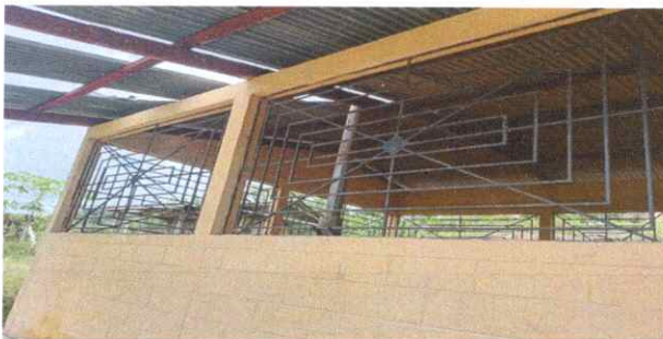
Foto 5: Mantenimiento de balcones de metal
