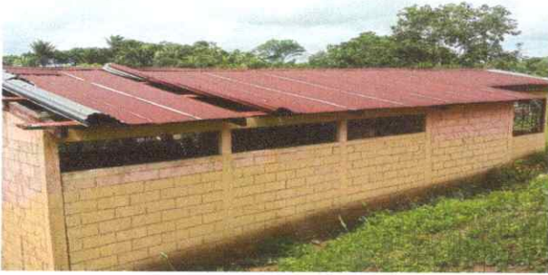
Foto 1: sustitucion de lamina , por lamina troquelada aluzinc
