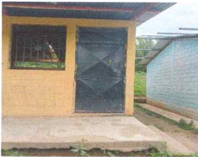
Foto 3: Mantenimiento de estructura en puerta
