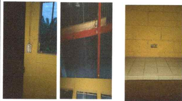
Foto 4: Reparacion de sistema electrico
