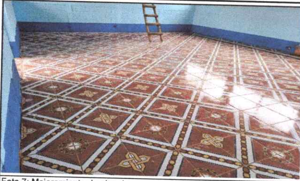
Foto 7: Mejoramiento de piso de cemento líquido a piso cerámico
