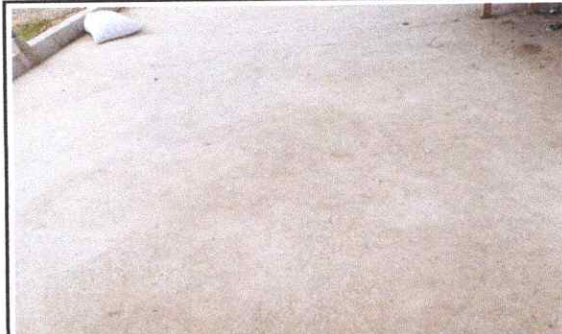
Foto 6: Sustitución de piso torta de concreto
