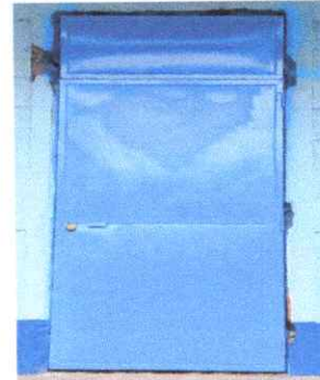
Foto 2: Sustitución de puerta
