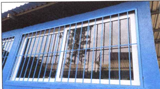
Foto 5: Sustitución de balcones de metal
