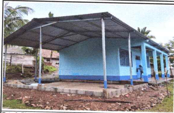
Foto 8: Pintura en muros exteriores e interiores
