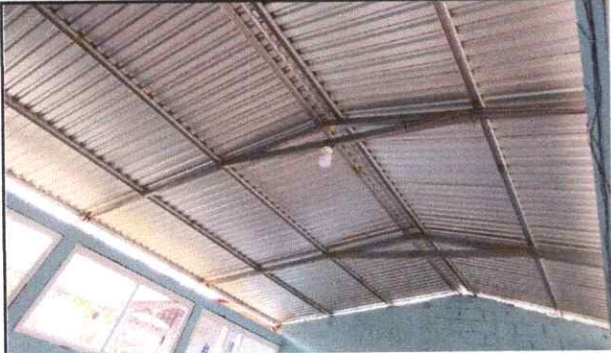
Foto 1: Sustitución de lámina por lámina troquelada aluzinc calibre 26 y Sustitución de estructura de soporte de metal, por metal.
