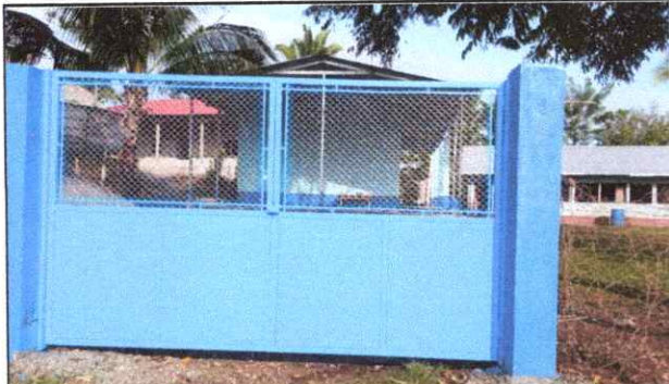
Foto 3: Sustitución de portón de metal
