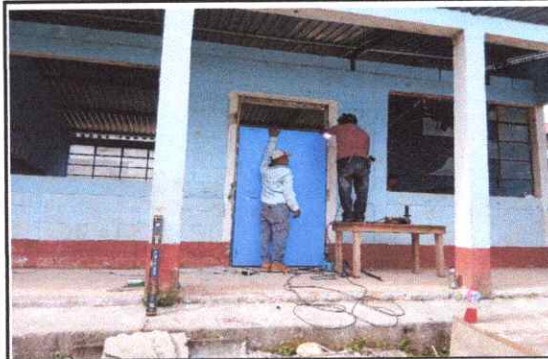
Foto 2: Sustrucción de puerta
