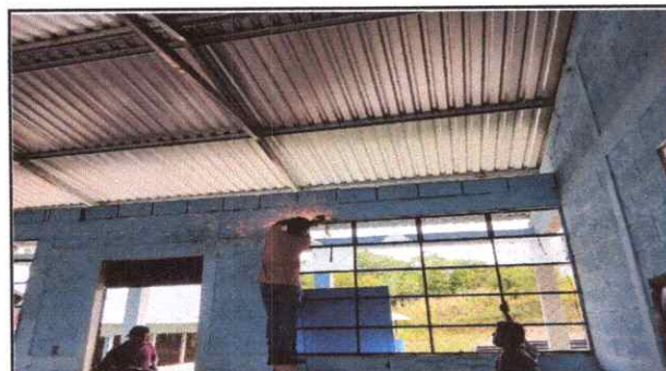
Foto 5: Sustrucción de balcones de metal
