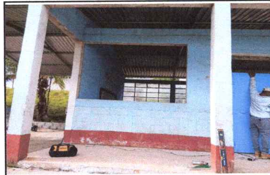
Foto 4: Sustrucción de estructura de metal de ventana por ventana de PVC
