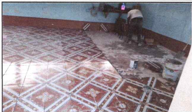
Foto 7: Mejoramiento de piso de cemento líquido a piso cerámico
