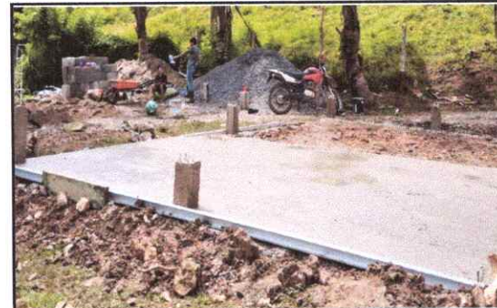
Foto 6: Sustrucción de piso torta de concreto
