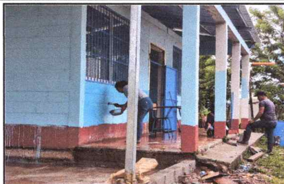
Foto 8: Pintura en muros exteriores e interiores
