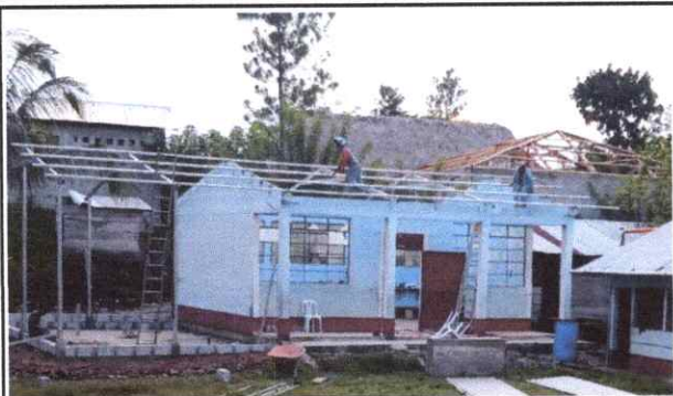
Foto 1: Sustrucción de lámina por lámina troquelada aluzinc calibre 26 y Sustrucción de estructura de soporte de metal, por metal.
