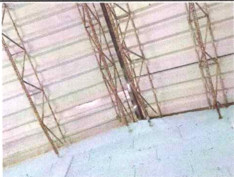
Foto 1: Sustitución de lámina por lámina troquelada aluzinc calibre 26 y Sustitución de estructura de soporte de metal, por metal
