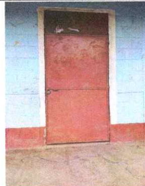
Foto 2: Sustitución de puerta
