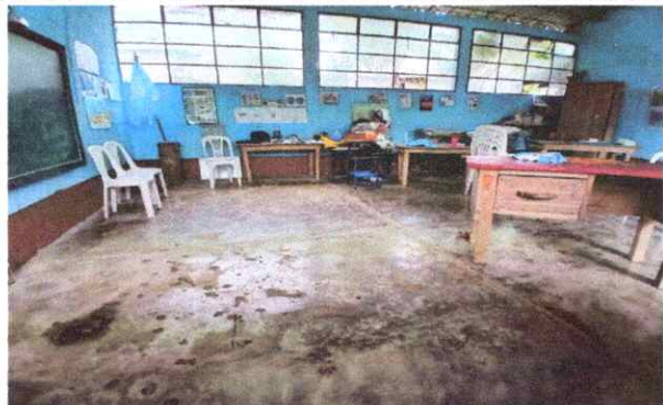
Foto 7: Mejoramiento de piso de cemento líquido por piso cerámico
