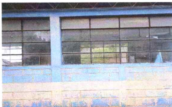
Foto 5: Sustitución de balcones de metal
