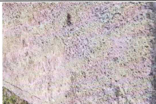
Foto 6: Sustitución de piso torta de concreto
