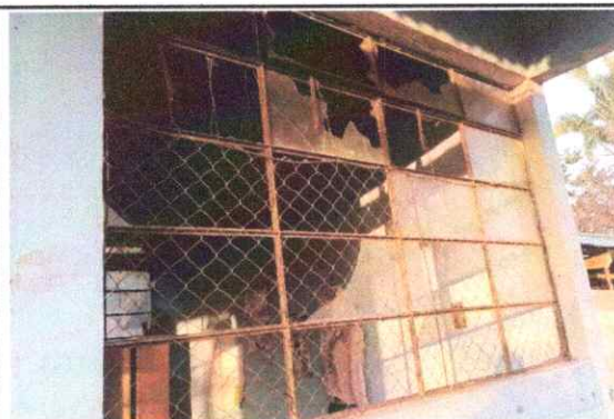
Foto 4: Sustitución de estructura de metal de ventana por ventana de PVC.
