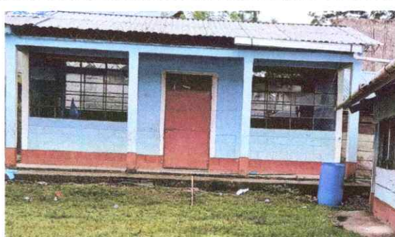
Foto 8: Pintura en muros exteriores e interiores
