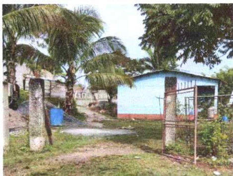
Foto 3: Sustitución de portón de metal
