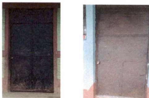
Foto 6: Mantenimiento a estructura (lijado,cambio de tubo, sepillado, sujeciones, aplicación de pintura.)
