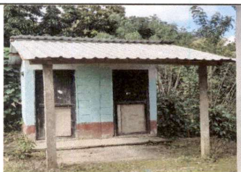
Foto 5: . Sustitución de puertas en servicio sanitario.
