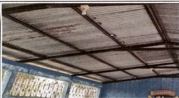
Foto1: Sustitución de lamina por lamina troquelada calibre 26.
