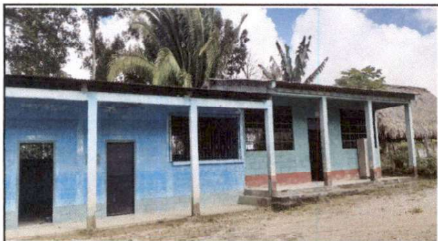
Foto 3: Pintura en muros interiores y exteriores.
