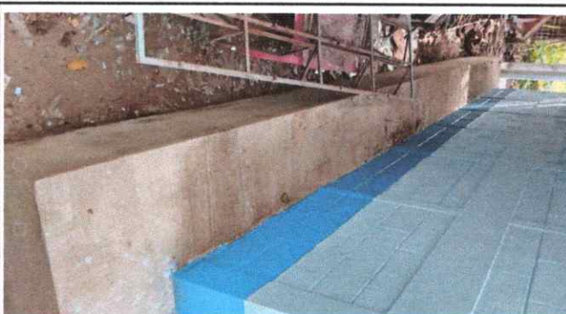
Foto 4: MURO DE CONTENCIÓN
