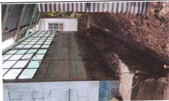
Foto 4: MURO DE CONTENCIÓN
