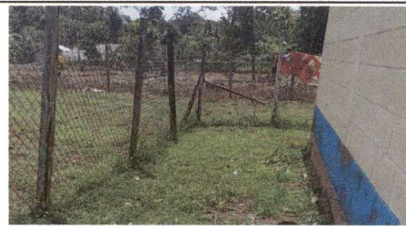
Foto 4: Reparación de cerco de alambre de púas.
