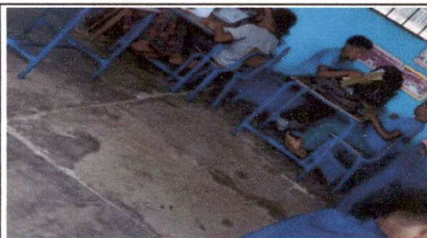
Foto 4: Sustitución de piso de cemento líquido
