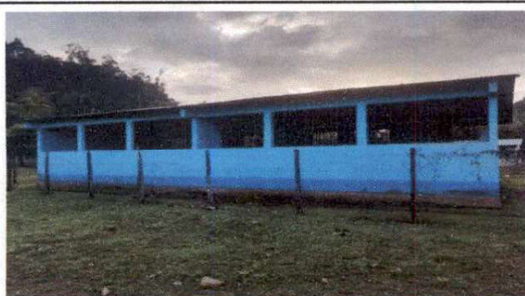
Foto1: Pintura en muros exteriores e interiores
