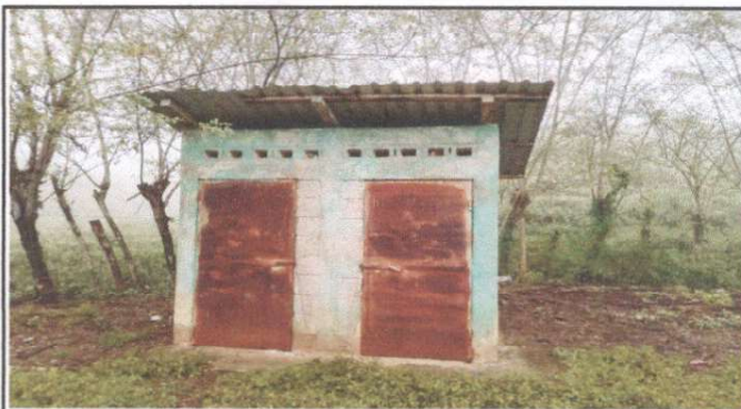
Foto 4: Mantenimiento a estructura (lijado, cambio de tubo, cepillado, sujeciones, aplicación de pintura) a puertas servicios sanitarios
