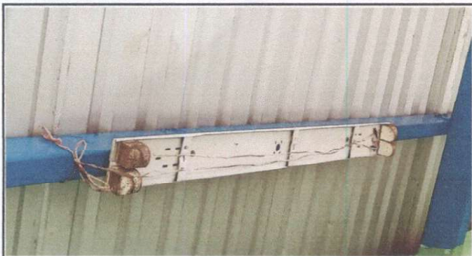
Foto1: SUSTITUCION DE LAMPARAS TIPO LED, REPARACION DE CABLEADO ELECTRICO
