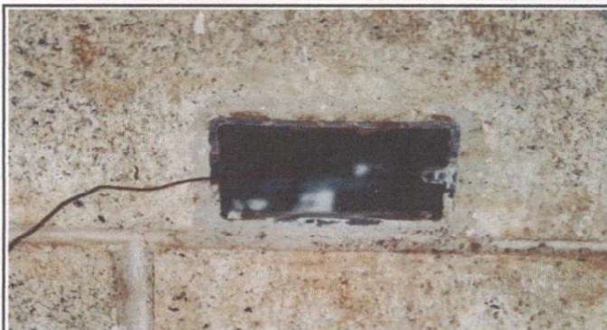
Foto 2: SUSTITUCION DE TOMACORRIENTES DOBLES
