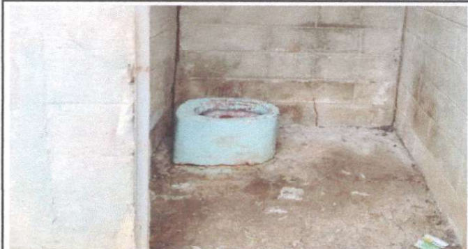
Foto 4: SUSTITUCION DE INODOROS
