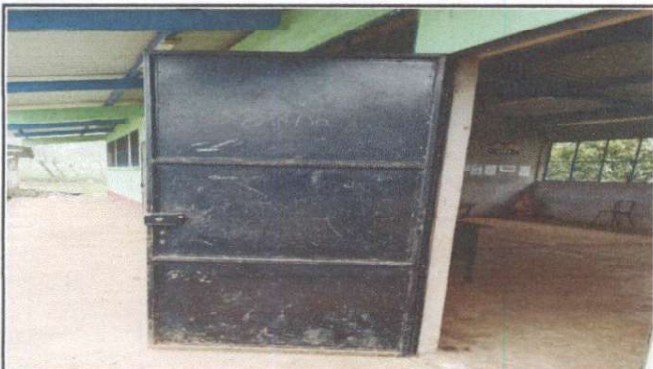
Foto 3: SUSTITUCION DE PUERTA
