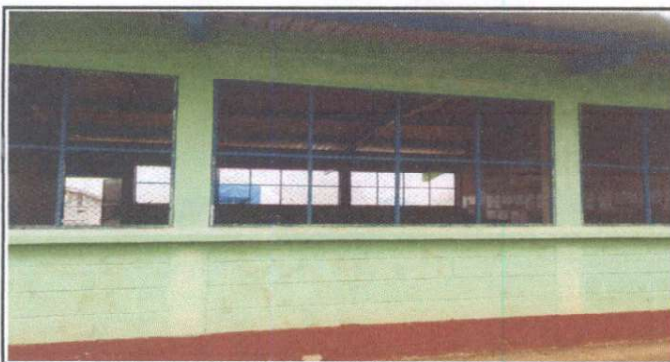
Foto 5: SUSTITUCION DE BALCONES DE METAL
