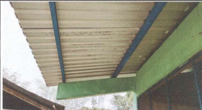
Foto 2: MANTENIMIENTO A ESTRUCTURA DE SOPORTE DE METAL
